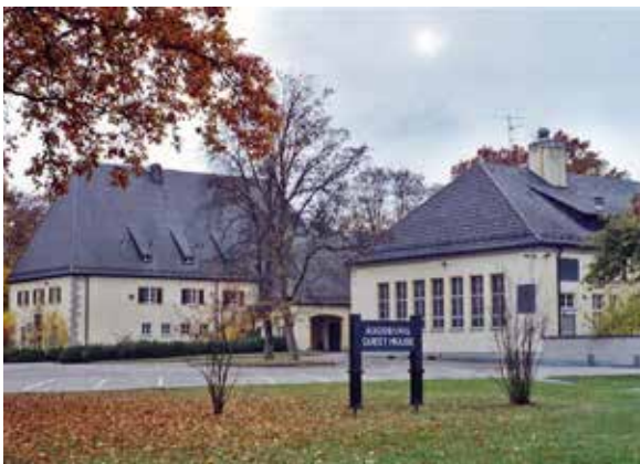
Casino: Ansicht Haupteingang während der militärischen Nutzung des Areals (Bild: Amerika in Augsburg e. V.)
